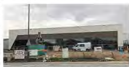
Le bâtiment est en cours de finition rue Einstein.
